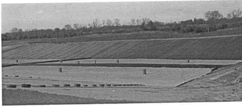
4. ábra: Műszaki védelemmel ellátott hulladéklerakó medence, II/B ütem, Kökény
